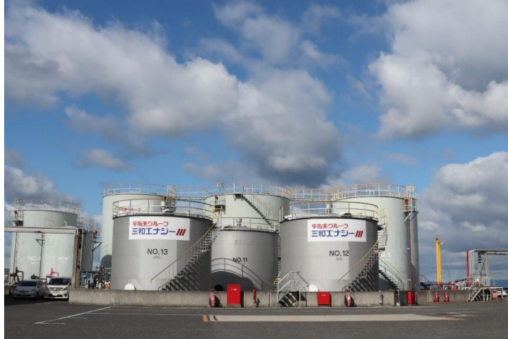
三和エネルギー岸和田油槽所/岸和田バイオプラント
